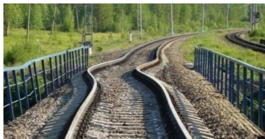
Рисунок 1 – Выброс пути при повышении температуры рельса
